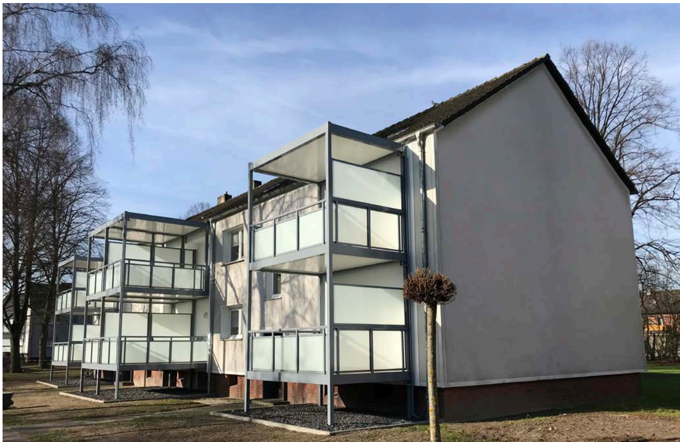
► Schöne und große Balkone für die Wohnungsnutzer der Dorstener Str.387-401 in Oberhausen-Osterfeld
