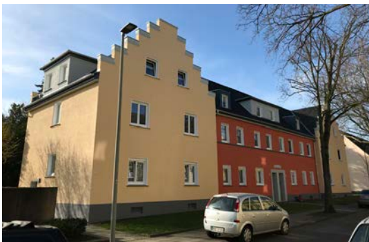
► Die Fassaden der Häuser Hahnenstr. 11-19 und 21-23 erstrahlen in neuem Glanz
