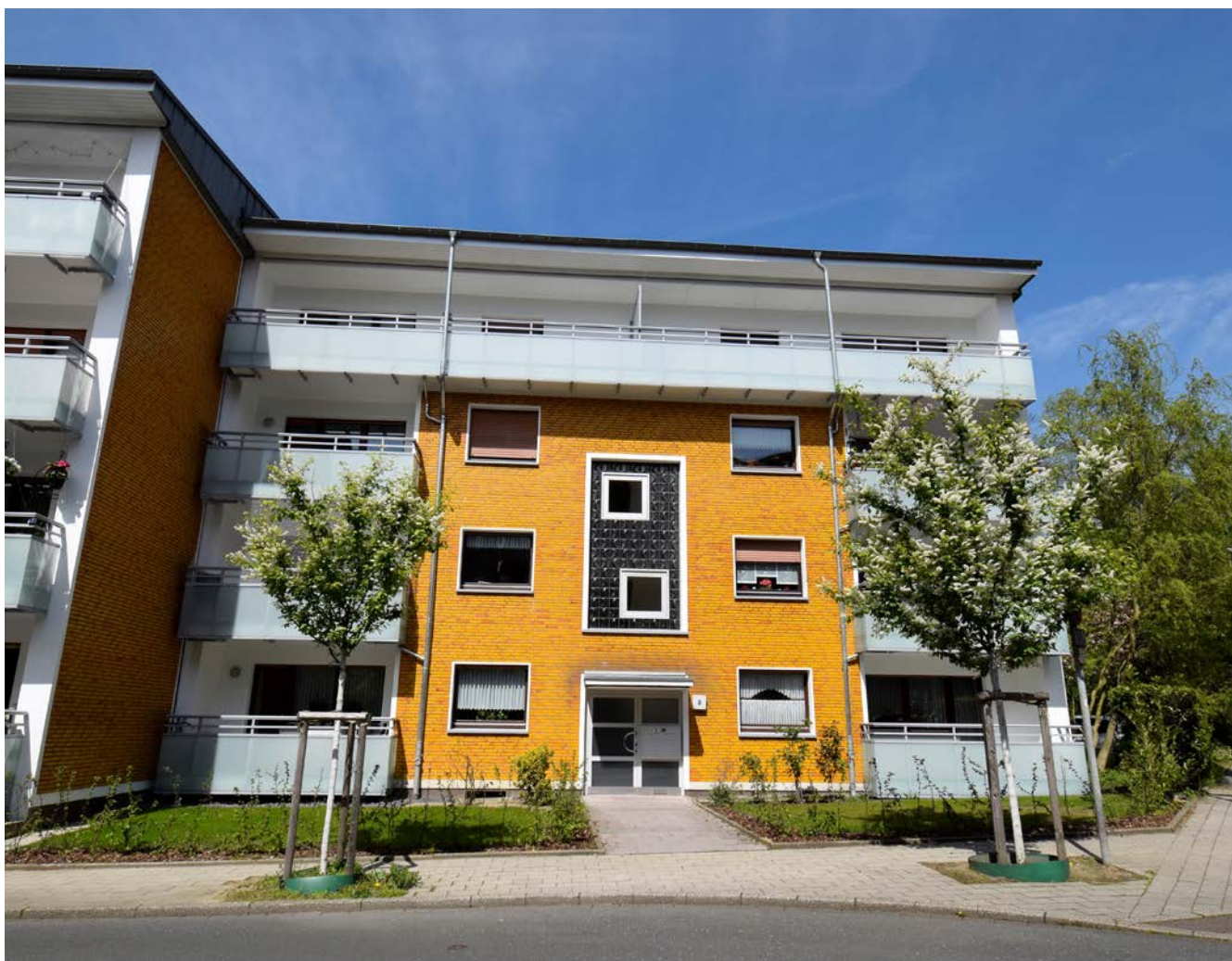
► Programm zum Anbau von Vorsatzbalkonen an den Häusern Völklinger Str. 7-9 weiter fortgesetzt
