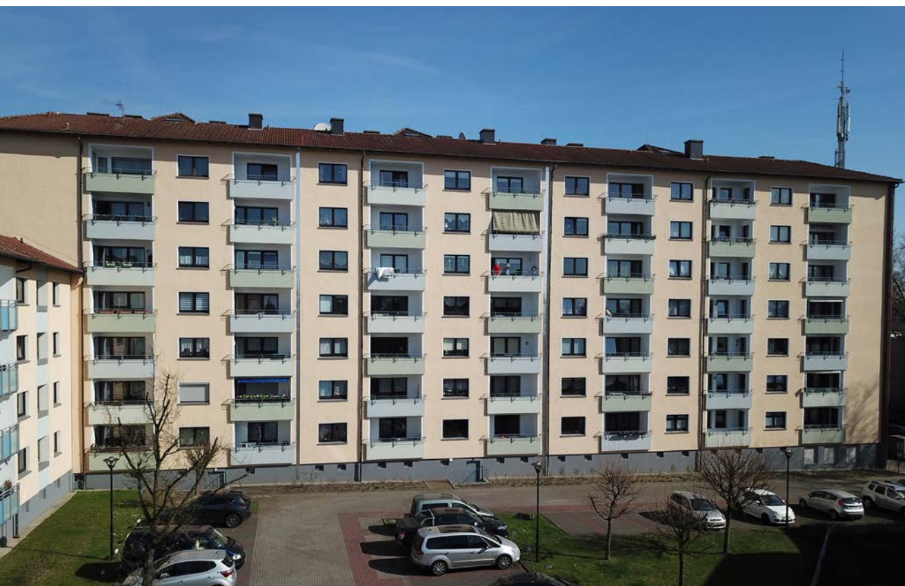
► Umfangreiche Sanierung der Wohnhäuser Waisenhausstr. 25-29 in Oberhausen
